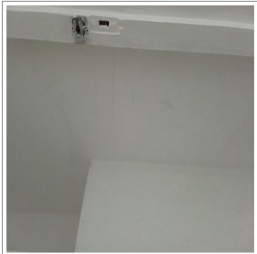
Hall d'entrée : Placard : intérieur peint
