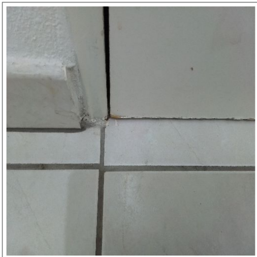
Hall d'entrée : Porte palière : Bois peint
