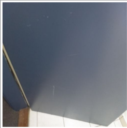
Hall d'entrée : Porte palière : Bois peint
