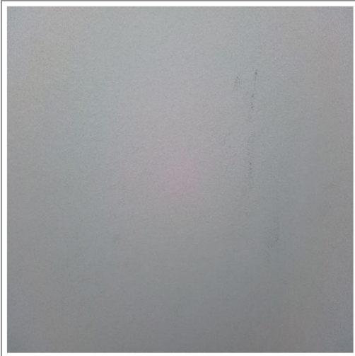
Hall d'entrée : Mur gauche : Crépi
