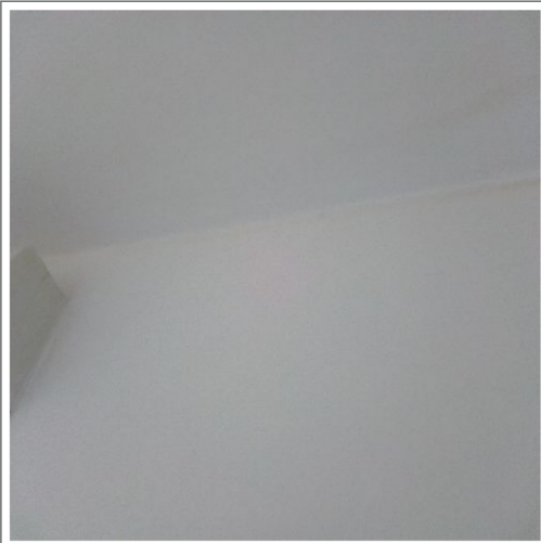
Cuisine : Mur droite : Crépi
