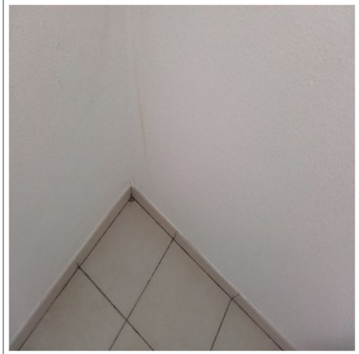
Cuisine : Mur droite : Crépi
