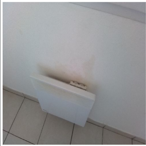
Cuisine : Mur droite : Crépi
